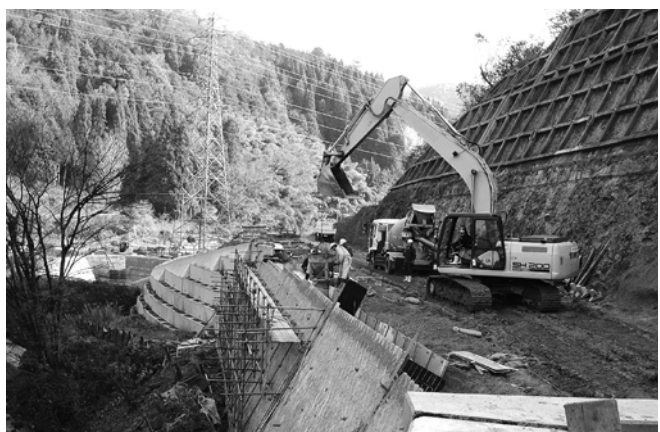
▲進入道路部の作業状況
