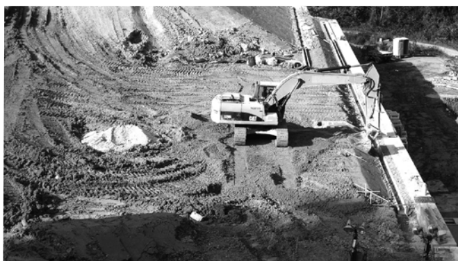
▲敷地造成部の作業状況
