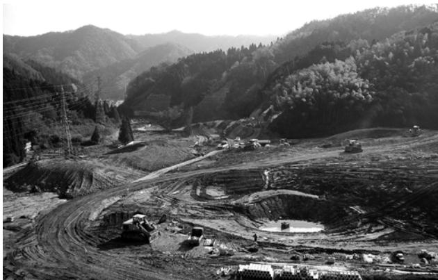
▲進入道路・敷地造成工事
