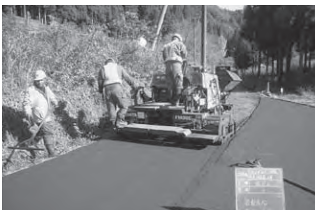
待避所設置工事
