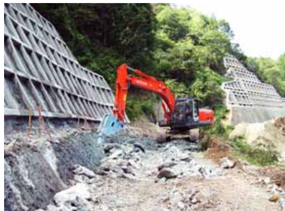
◀ 進入道路部の作業状況 (法面部の岩掘削)
