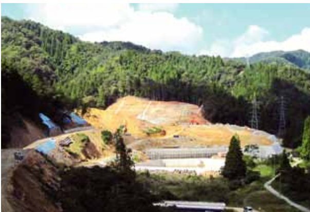
▶ 敷地造成部全景
